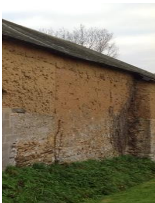
Mur en terre crue au Molay-Littry
