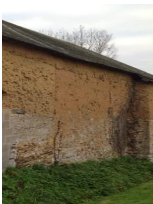
Mur en terre crue au Molay-Littry
