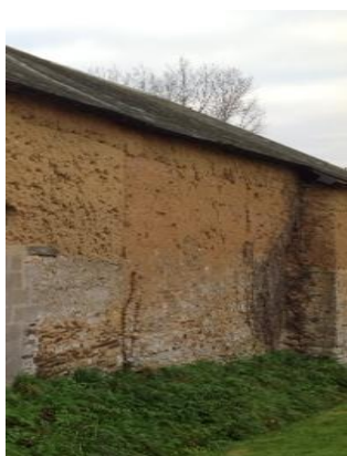
Mur en terre crue au Molay-Littry
