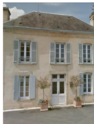
Façade en enduit traditionnel à la chaux à Trévières
