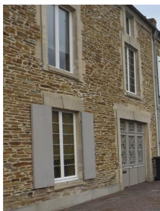
Façade en schiste à Balleroy-sur-Drôme
