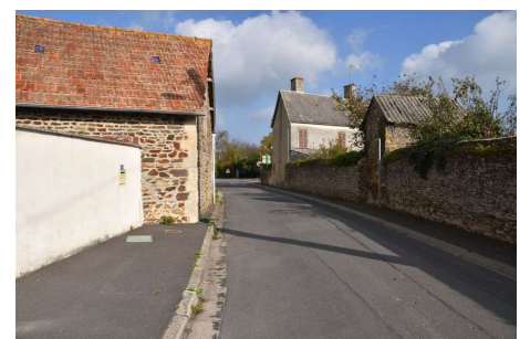
Etranglement en carrefour où la distance entre bâtis n'est pas sécuritaire.
